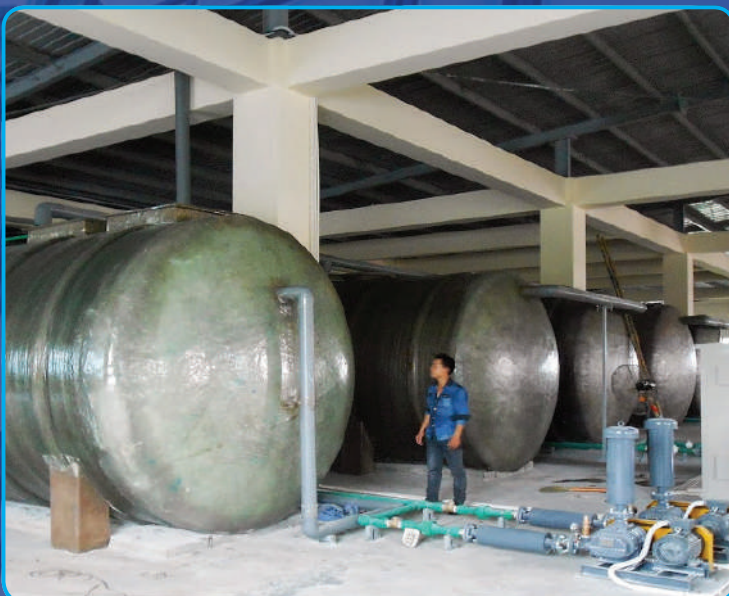
Bồn composite xử lý nước thải được vận chuyển, lắp đặt tại đến công trình.
